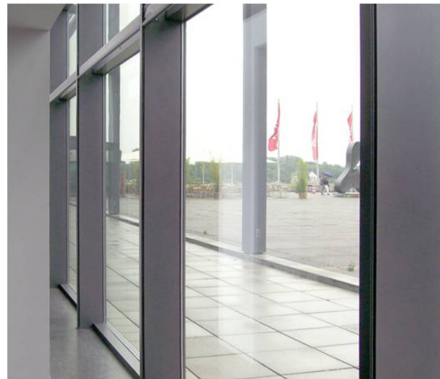
Sichtbehinderung durch Stahl-Profile in einer Pfosten-Riegel-Konstruktion
