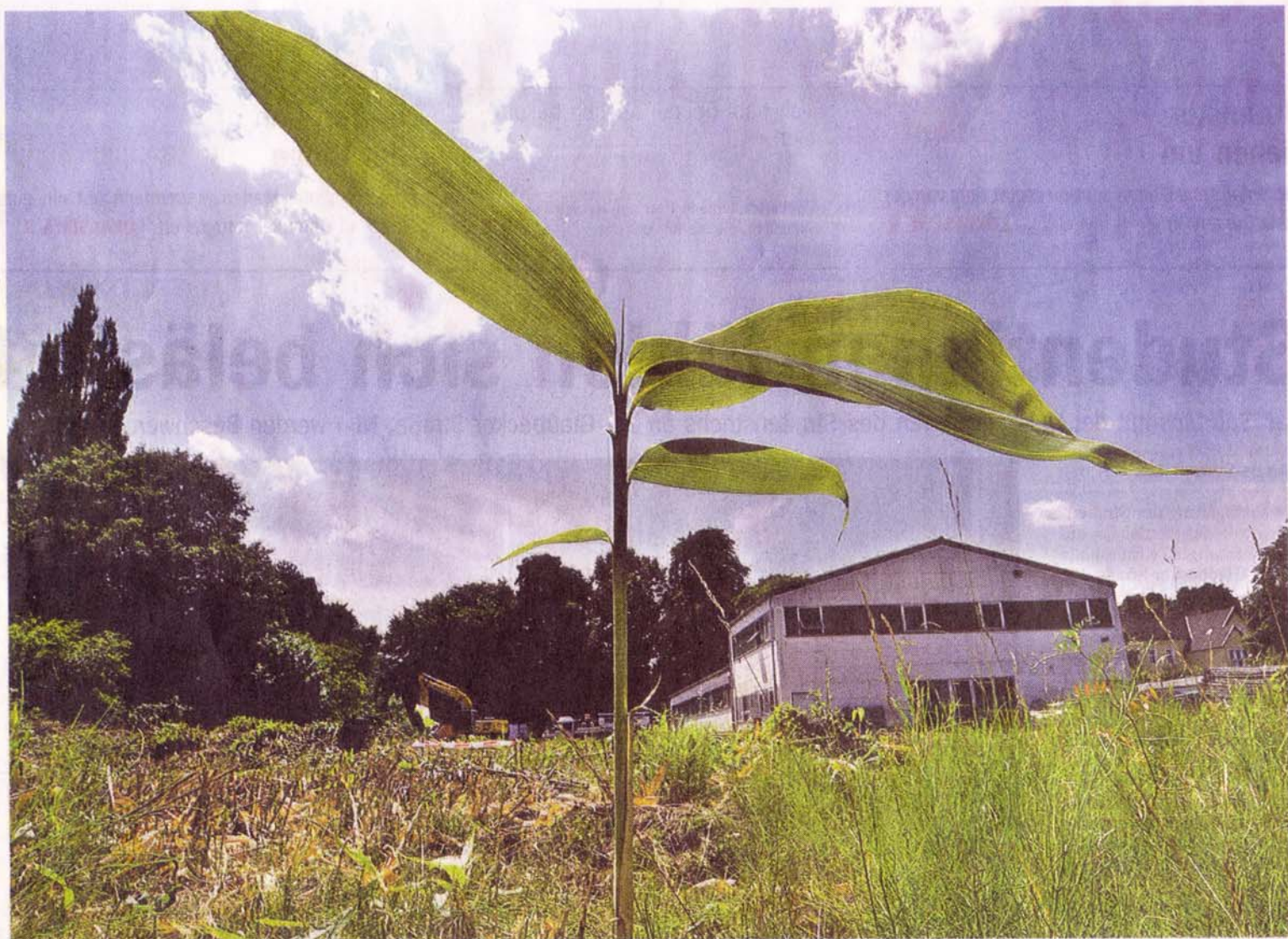
Am Külshammerweg haben die Bauarbeiten für zwei neue Gewächshäuser begonnen. Im Februar 2010 wird die Universität hier ihren Botanischen Garten einrichten. Das Land investiert drei Millionen Euro in den Neubau.
