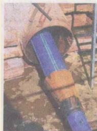
In ein altes Wasserrohr wird ein kleineres gelegt. Foto: Gelsenwasser
