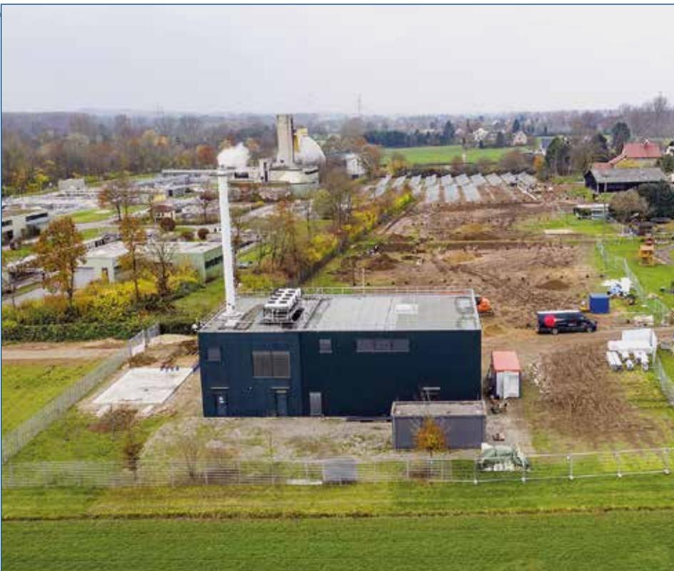
Im Klärwerk der Stadt Lemgo (hinten links) steht die automatisierte Großwärmepumpe, im vorderen Teil das neue Blockheizkraftwerk für die Fernwärme. Hinten rechts ist die neue Solarthermie, die aufgrund der Erfahrungen des Projekts InSekt gebaut wurde.
