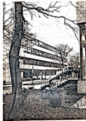
Studierende auf der Treppe von Gebäude LB 1972. FOTO UNIVERSITÄTSARCHIV
