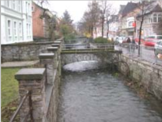
„Urbanisation“ am Westernbach in Warstein
