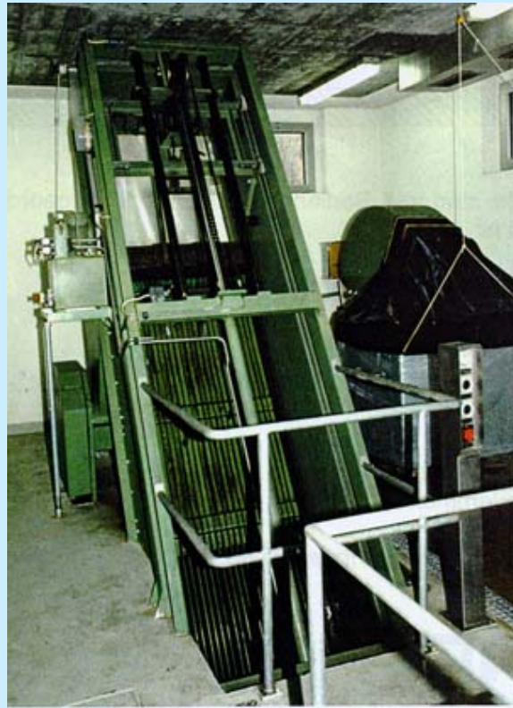
Greif- bzw. Umlaufrechen (DIN 19554 T.1) Reciprocating rake bar screen
