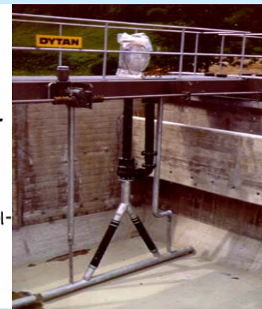
Saugräumung im Rundbecken suck scraper in round tanks
