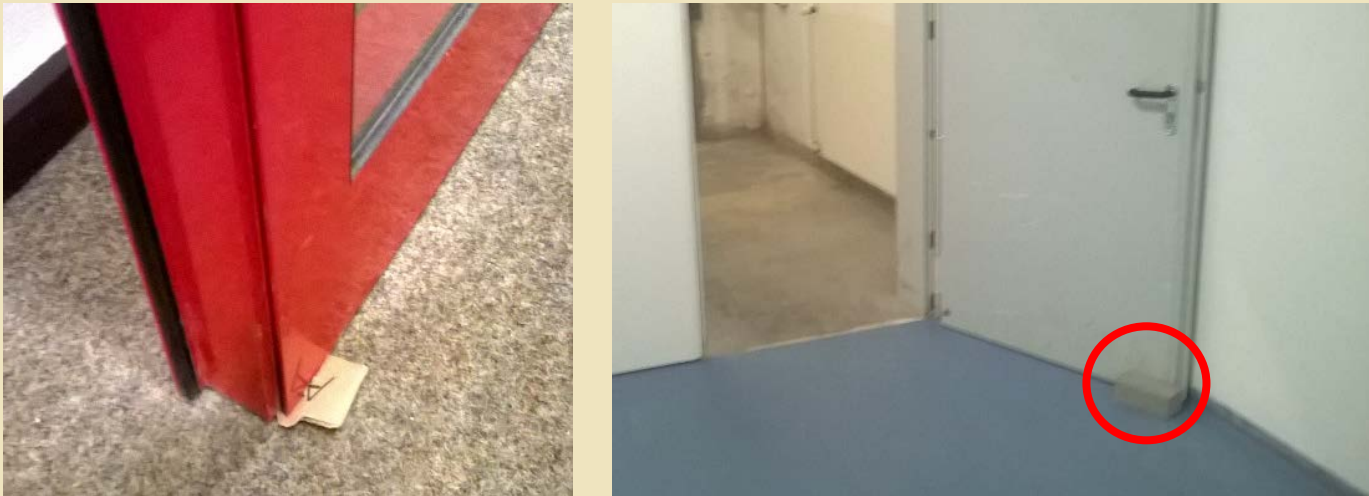
Abbildung 2: Beispiele für Manipulationen an Brandschutztüren
