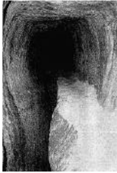
Abb. 1: Inneres des Tunnels mit Weg und Wasserkanal, Kienast 1986/87, 183
