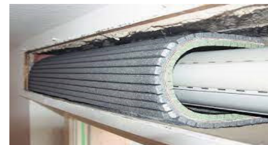
Rolladenkasten dämmen
