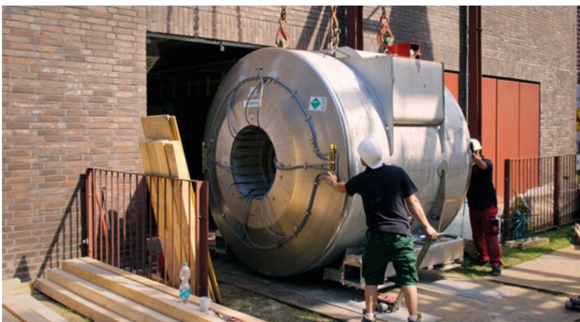
Einbringung des 7-Teslamagneten in das ELH
