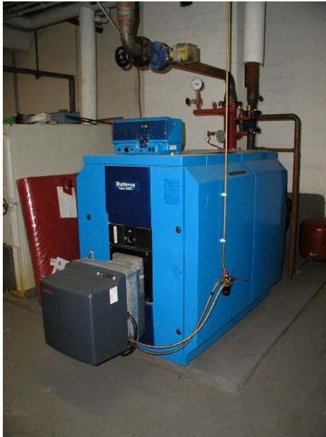
Abb. 7 Niedertemperaturkessel 290 kW (Buderus Logano GE 515, Ölbrenner)
