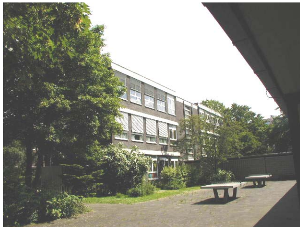
Abb. 1 Ansicht Hautgebäude (Bauteil I wie Bauteil II)
