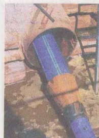
In ein altes Wasserrohr wird ein kleineres gelegt. Foto: Gelsenwasser
