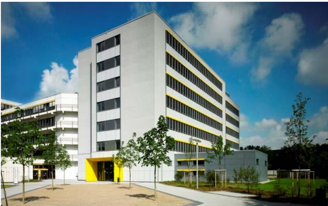
Das S07 Gebäude am Campus Essen verfügt über fast 100 moderne Laborräume für die Fachrichtung Chemie.
