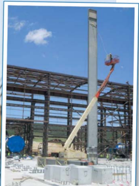
Aktuelle Nachrichten von der Baustelle in Denizli: Am 24. Mai wurde die erste Kesselstütze gesetzt. „Bei einem GuD-Kraftwerk ist das anders als etwa bei einem Kohlekraftwerk zwar kein Meilenstein, aber es markiert den Beginn des Kesselbaus“, sagt Baustelleningenieur Delf Dubslaff. Nach türkischer Tradition wurde auf der Baustelle ein Lamm geopfert – für einen erfolgreichen Fortgang der Arbeiten beim Kesselbau.
