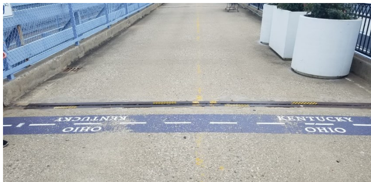
Die Grenze zwischen Kentucky und Ohio auf der „Purple People Bridge“
