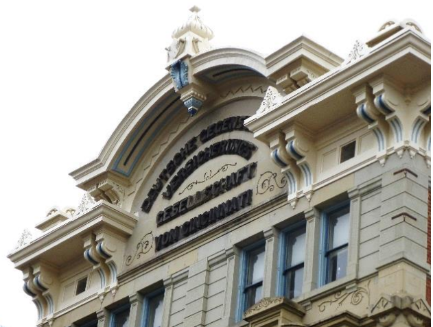
Das Gebäude der Deutsche Gegenseitige Versicherungsgesellschaft von Cincinnati ist heute noch als Germania Building bekannt. CC BY-NC DE 3.0 Katharina Graef
