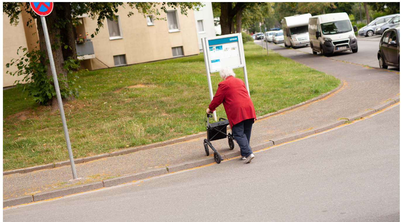
Abb. 110: Fehlende Bordsteinabsenkung / Quelle: eigene Darstellung
