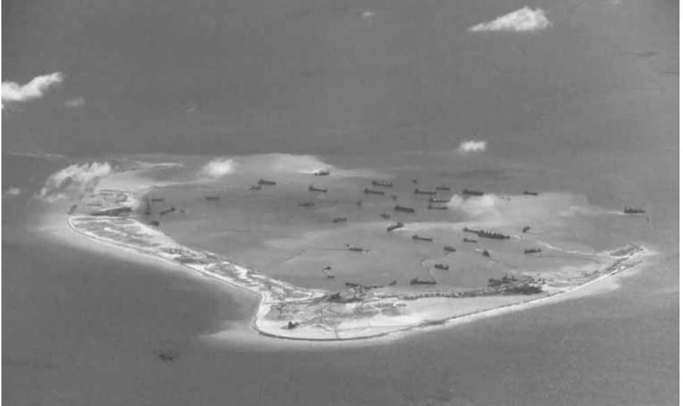
Mischief Riff in der Spratly-Gruppe. Chinesische Spezialschiffe saugen Sand vom Meeresgrund ab und spülen ihn auf das Korallenriff auf. Quelle: Christian Science Monitor 6.8. 2016 (US Navy Mai 2015)
