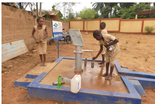
Fig. 29 : Un puits India Mark-II à pompe manuelle, financé par un donateur privé du Bénin, est installé près de l'école, à seulement 20 m de la cuisine.
