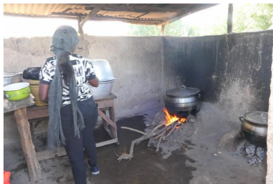
Fig. 19 : Ici aussi, les murs sont beaucoup trop hauts, de sorte que la fumée (plus lourde que l'air) ne peut pas s'échapper.
