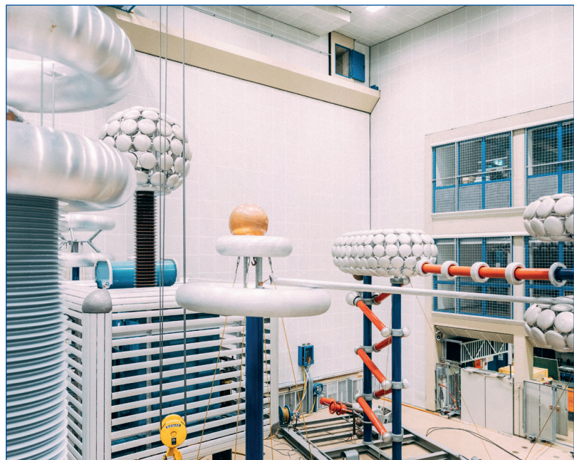
Meilenstein erreicht im Hochspannungslabor des Fachbereichs Energietransport und -speicherung
