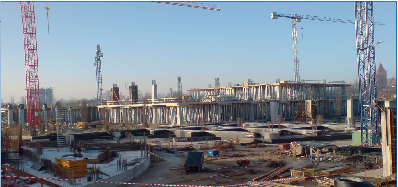
Funktionierende Kreisläufe statt linearer Stoffströme am Bau
