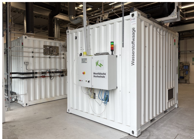
In der Windstrom-Elektrolysehalle wird mit erneuerbarem Strom Wasser in Wasserstoff und Sauerstoff gespalten.
