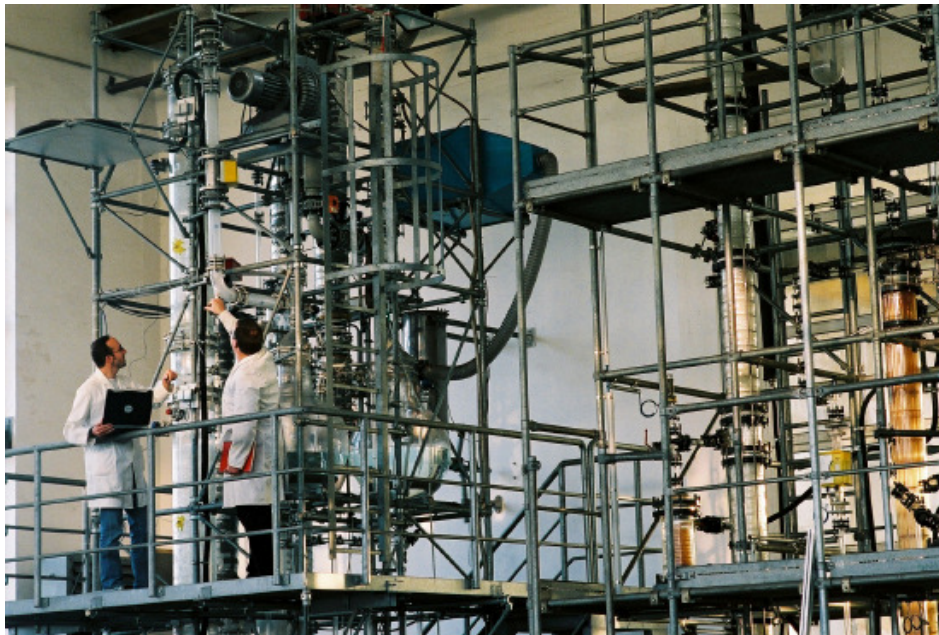
Foto: 2-stufige Rauchgaswäsche (Technikumsanlage am IUTA)
