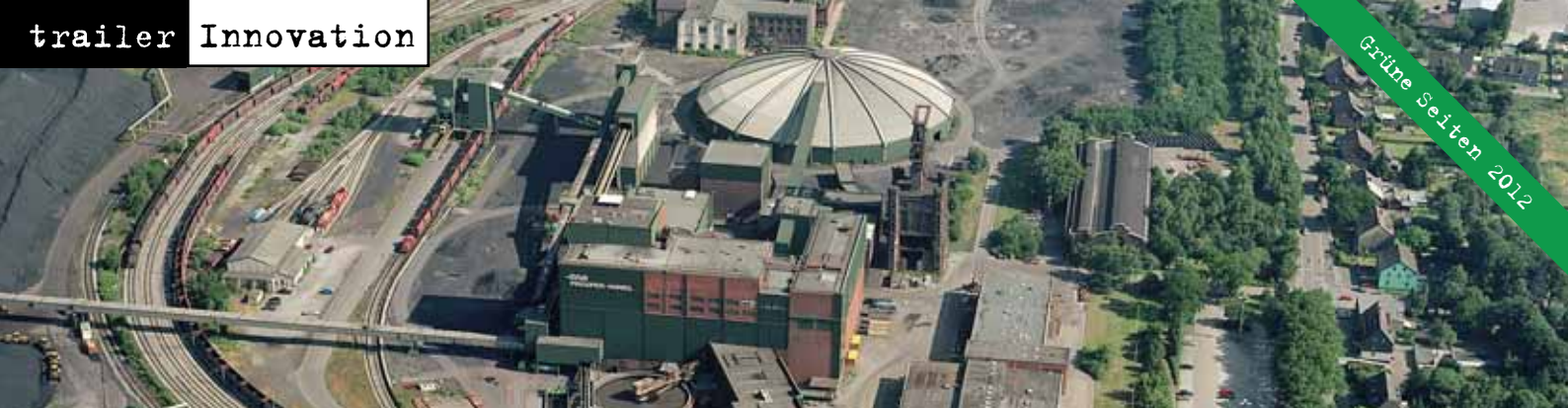
Machbar ist es: Revier-Wissenschaftler und die RAG arbeiten daran, Erneuerbare Energien in Bergwerken wie „Prosper-Haniel“ zu speichern, Foto: RAG
