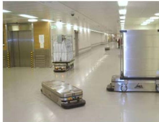
Fig. 2: FTF im Krankenhaus (Quelle: MLR System GmbH)
