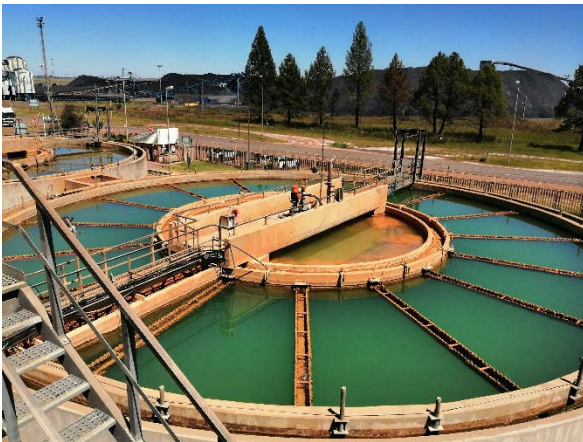
Absetzbecken zur Aufbereitung von Grubenwasser
