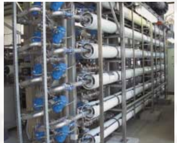
Bild 6: Großtechnische Pilotanlage (150 m 3 /h) nach dem XIGA-Konzept beim WdKA
