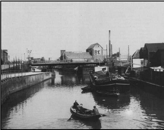
Abb. 3: Spoykanal und die "Herzogbrücke" (um 1930) 19
